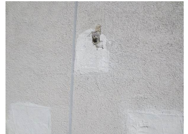
Billede 12 - pudsskader på sydvendte gavle ved kældernedgang
