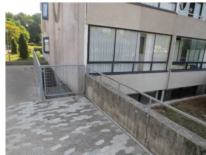
Billede 41 - terræn over utæthed i mellemgangen fra bygning 2 til 3
