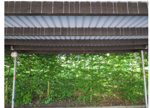
Billede 50 - løbere på carportenes trækonstruktion kommer muligvis fra ståltrapezpladernes overfladebehandling
