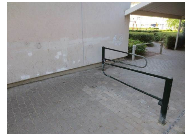
Billede 14 - pergolagangen er placeret med bomme umiddelbart op ad bygningens nordvendte gavle. Dette medfører sammenstød når indkøbsvogne mv. skal manøvre rundt
