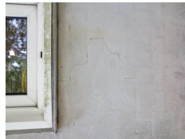
Billede 1 - revnet murværk ved vindue
