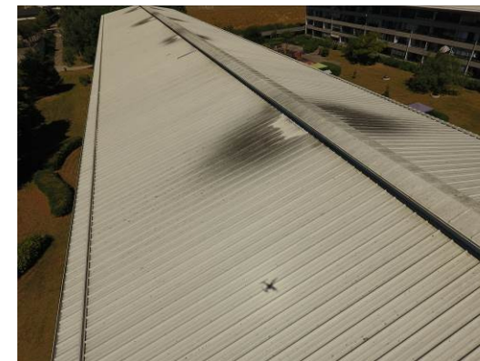
Billede 5 - tagflade med udluftning langs kip
