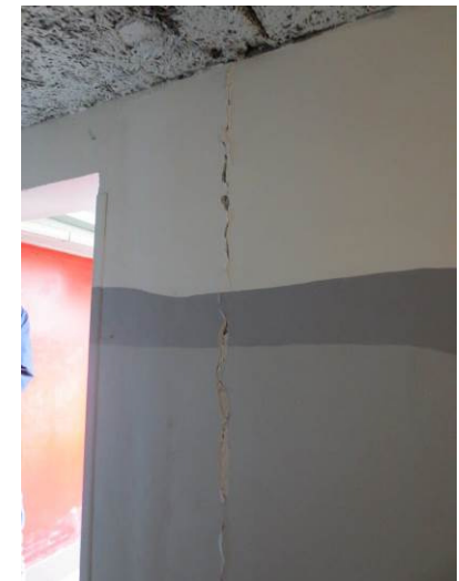
Billede 40 - revnedannelser og tegn på indtrængende vand i sammenbygningen
