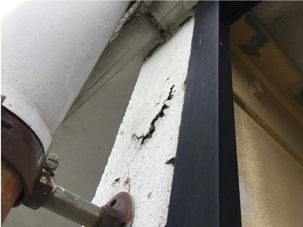
Foto 11. Høj blok. Blok 2 nr. 42 – 7.1, kant af vange. Der ses en begyndende afskalning og lodret revne.
