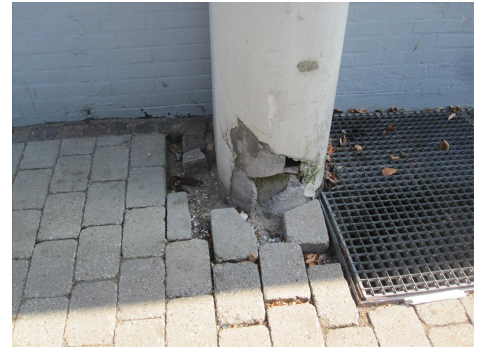
Billede 3 - skade på fiberbetonskal
