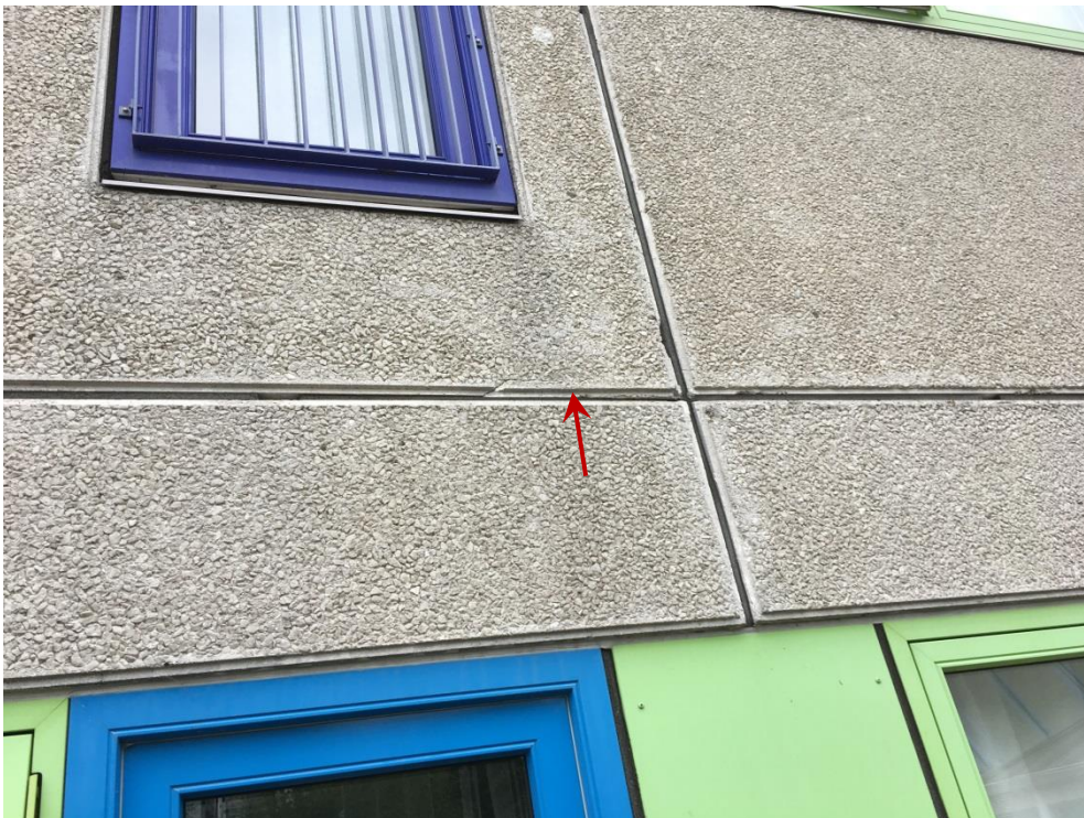
Foto 2. Lav blok. Blok 5, facade. Begyndende afskalning i bund af element.
