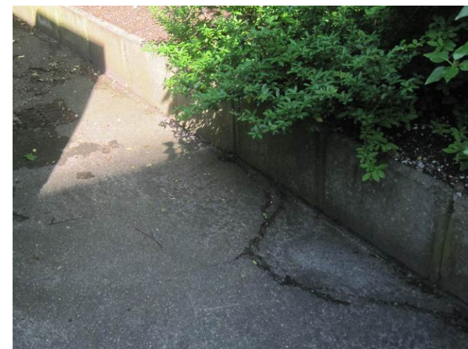
Billede 59 - revne i asfaltbelægning langs Poplens østvendte facade
