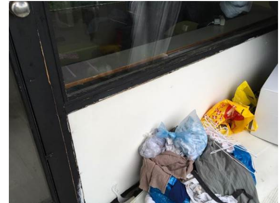
Billede 27 - afskallende maling på facadeparti mod altan
