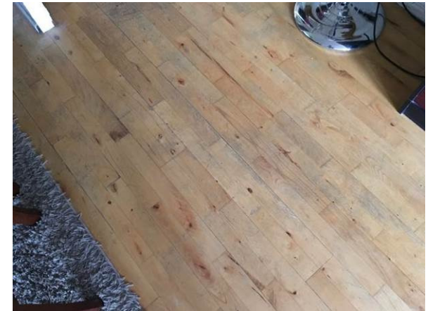
Billede 36 - de oprindelige gulve er slidte og knirkende områder er et generelt problem
