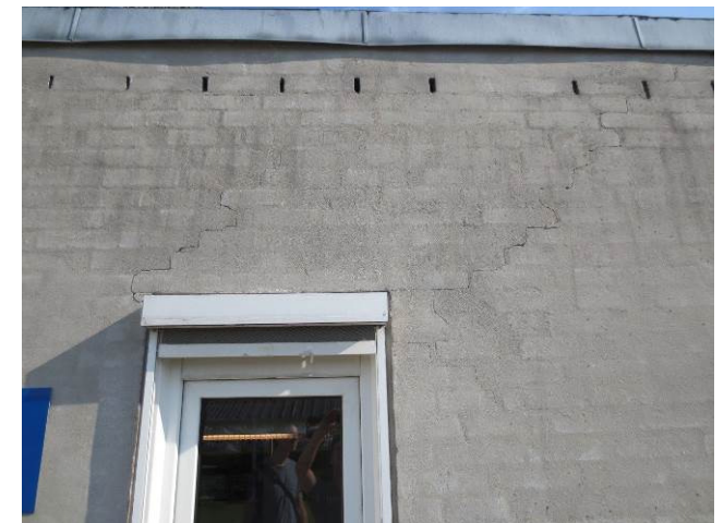
Billede 16 - der registreres skråt forløbende revner ud fra vindueshjørner i murværk på Beboerhuset, Bakken og Poplen
