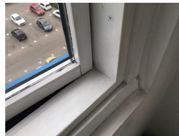
Billede 32 - begyndende råd i bundlister på vinduesrammer mod øst
