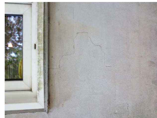
Billede 13 - revnet murværk ved vindue
