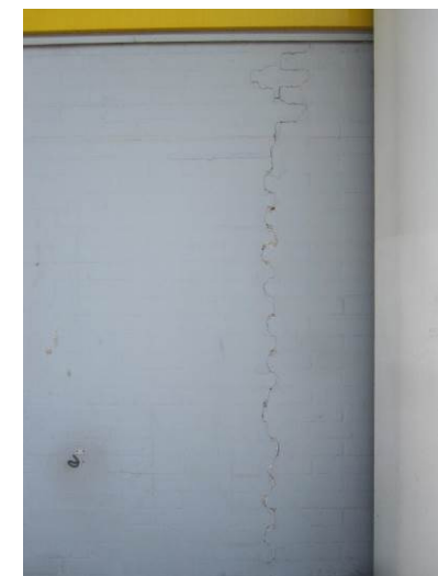
Billede 20 - eksempel på revner i murværk
