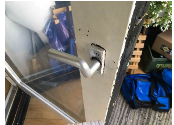
Billede 31 - løstsiddende greb på dør til altan
