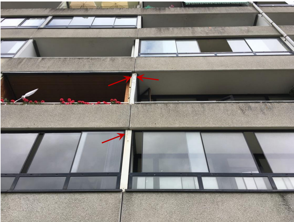
Foto 10. Høj blok. Blok 3, kant af vanger. Der ses begyndende afskalninger og lodrette revner (pile).
