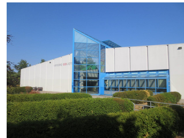
Billede 49 - ankomstareal ud for bygningens sydvendte gavl
