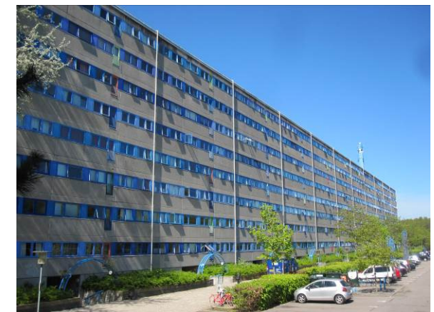
Billede 10 - facade mod øst
