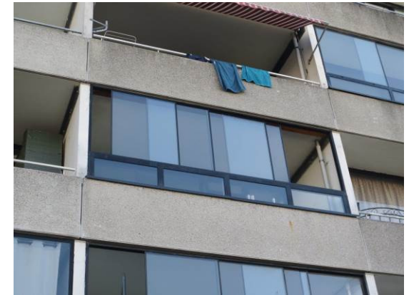
Billede 21 - glasparti/klimaskærm på altanbrystninger
