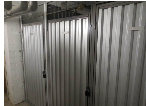
Billede 39 - nyere stål gitterpulterrum i kælder
