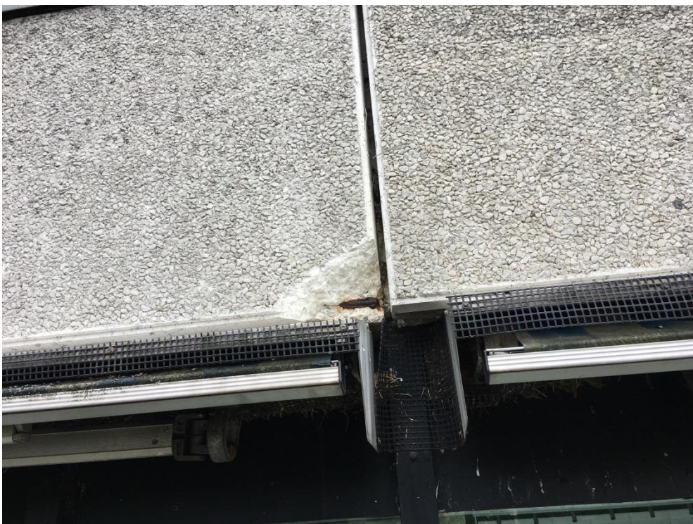
Foto 4. Høj blok. Blok 2, altanbrystning. Afskalning i nederste hjørne.
