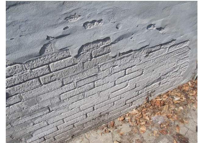
Billede 15 - forvitret brystningsmurværk på materialegårdens facade, hvor der tidligere har ligget salt umiddelbart op ad muren
