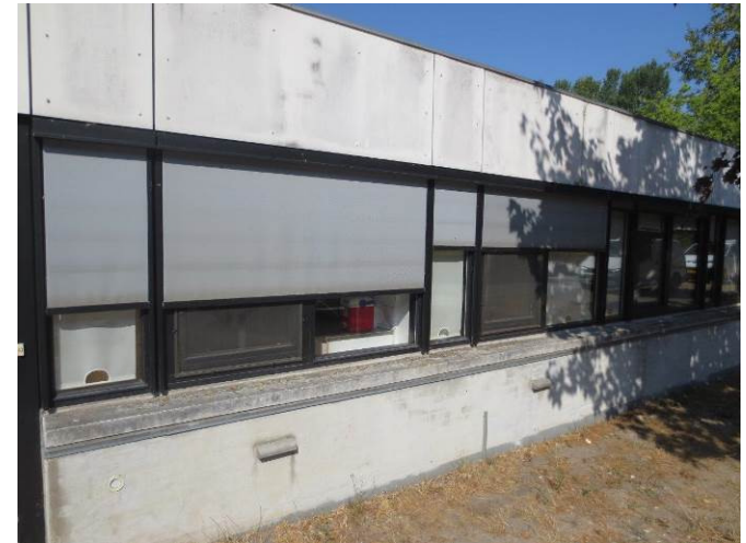
Billede 13 - Junibakkens facader skiller sig ud fra de andre institutioner med den murede brystning og vinduesbåndene
