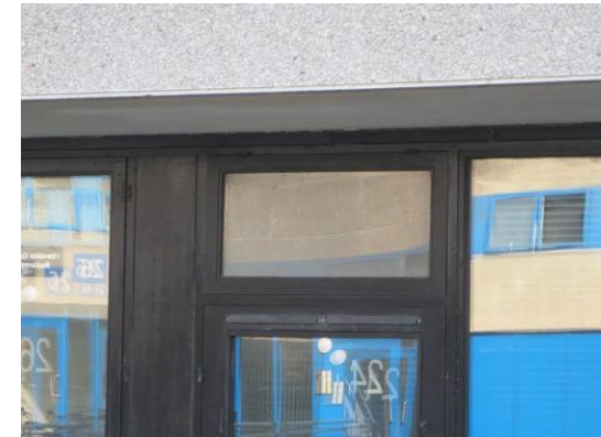
Billede 28 - 1-lags glas i vindue over dør i facadeparti
