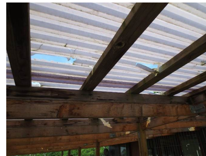
Billede 46 - huller i tagplader på boldklubbens terrasseoverdækning
