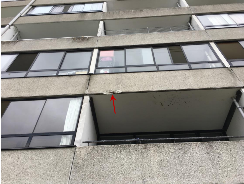
Foto 5. Høj blok. Blok 1, altanbrystning. Afskalning i bund.
