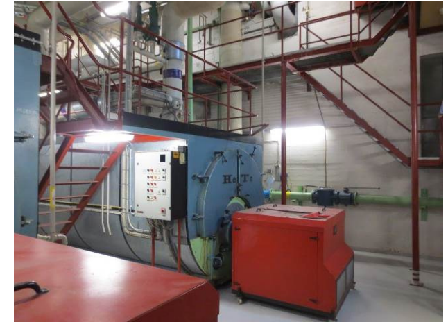
Billede 54 - overflader i varmecentralen
