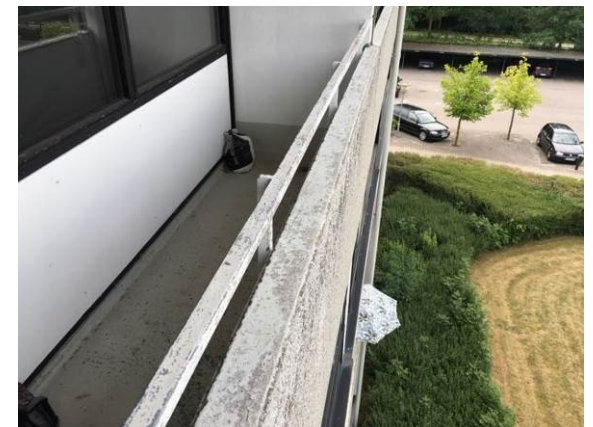
Billede 19 - altanbrystning og gelænder med afskallende maling
