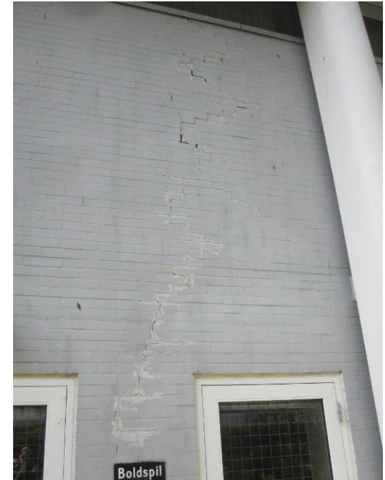
Billede 15 - sætningsrevner i fuger
