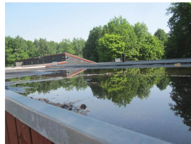
Billede 8 - manglende afvanding fra boldklubbens tagflade
