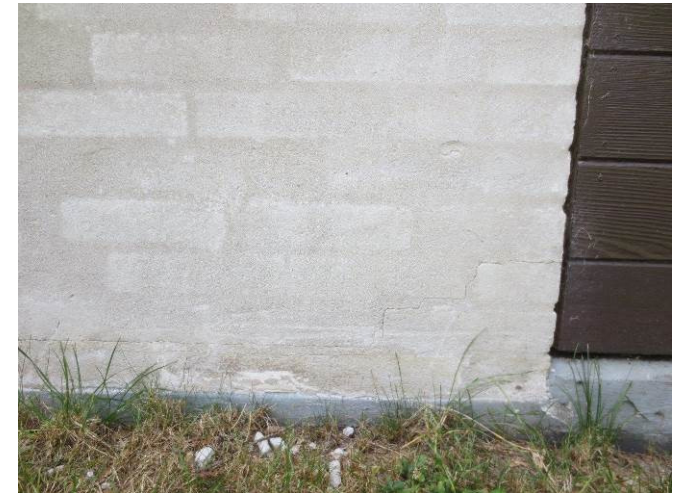
Billede 19 - vandret revne i første skift over sokkel
