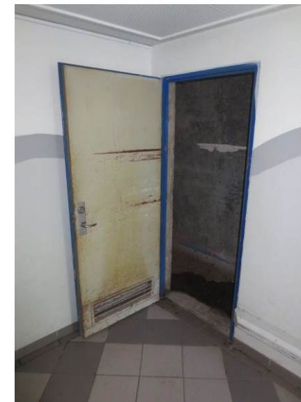
Billede 34 - dør til containerrum
