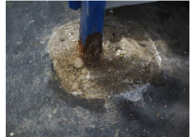
Billede 42 - opsvulmet kælderdæk i trapperum ved trappens fastmontering
