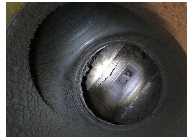
Billede 7 - manglende rengøring af kanalsystem
