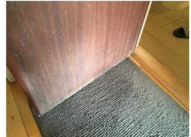
Billede 29 - badeværelsesdør med fugtskade
