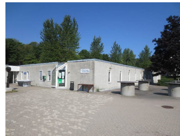
Billede 11 - beboerhusets kalksandstensmurede facader
