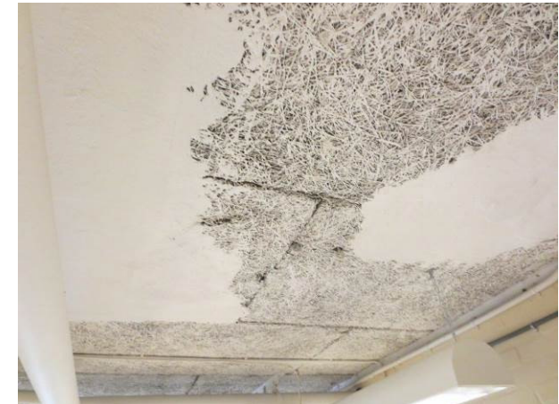
Billede 32 - kælderlofter fremstår med træbetonplader. Enkelte steder fremstår disse pudset
