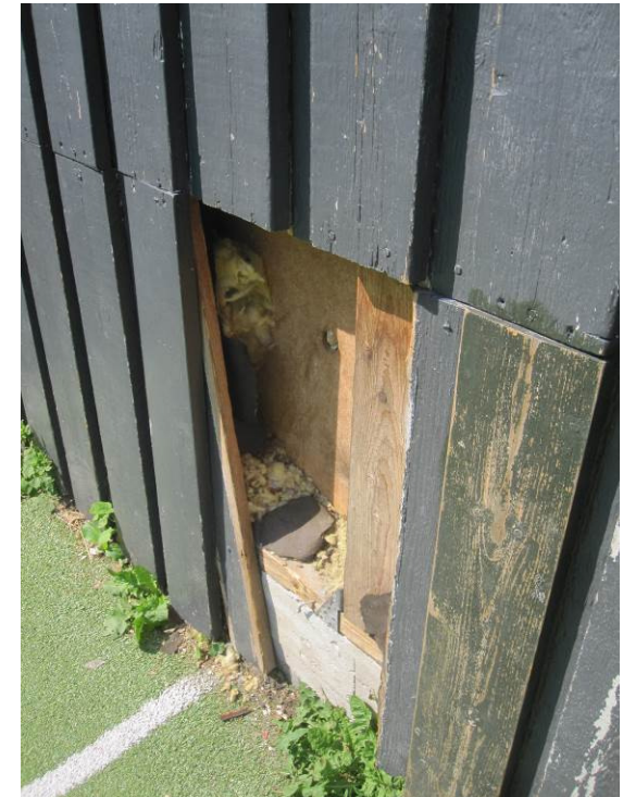
Billede 45 - åbentstående facade på boldklubbens skur er formodentlig levn fra en tidligere foretaget destruktiv undersøgelse, som aldrig er reetableret
