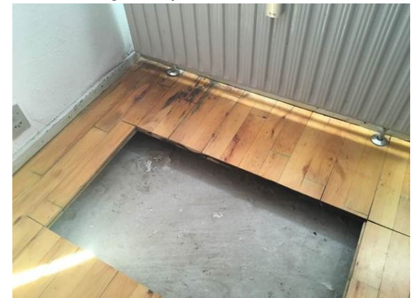
Billede 37 - åbning i gulv efter vandskade pga. utæt radiatorventil giver indtryk af gulvets opbygning. Isolering er her fjernet. Der ses stor afstand mellem strøer
