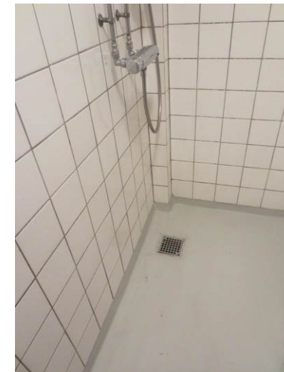
Billede 45 - malet gulvoverflade i bruseniche
