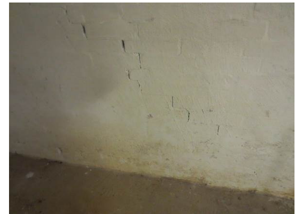
Billede 38 - saltudfældninger indvendigt på kælderydervægge af murværk
