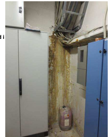
Billede 11 - skade på fiberbetonskal
