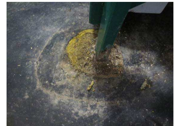
Billede 6 - vandskade ved trappers fastgørelse i kælderdek
