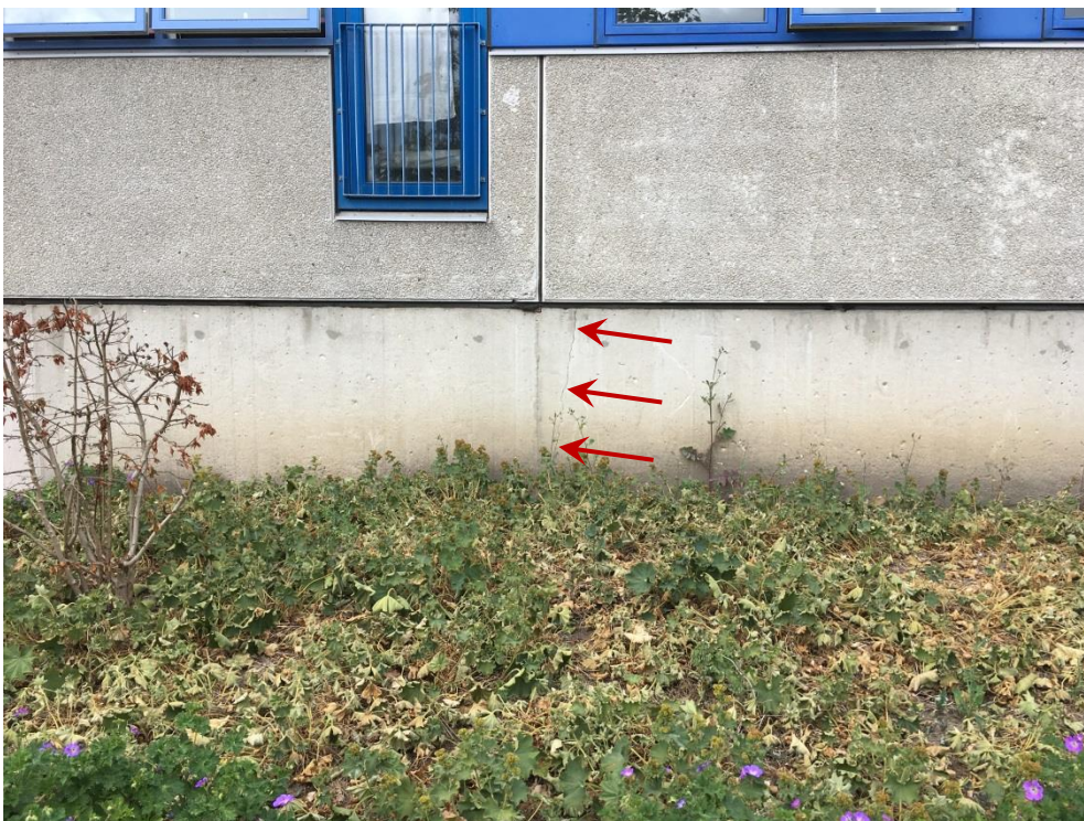
Foto 14. Høj blok. Blok 3, facade, kældervæg. Lodret revne (pil).
