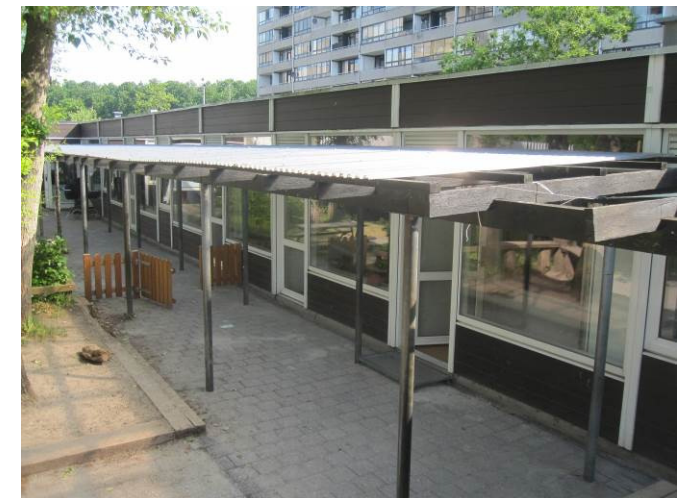
Billede 38 - terrasseoverdækning udført som espaliers langs Bakkens vestvendte facade
