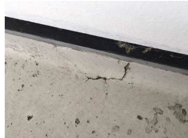
Billede 5 - betonafskalninger på altandæk
