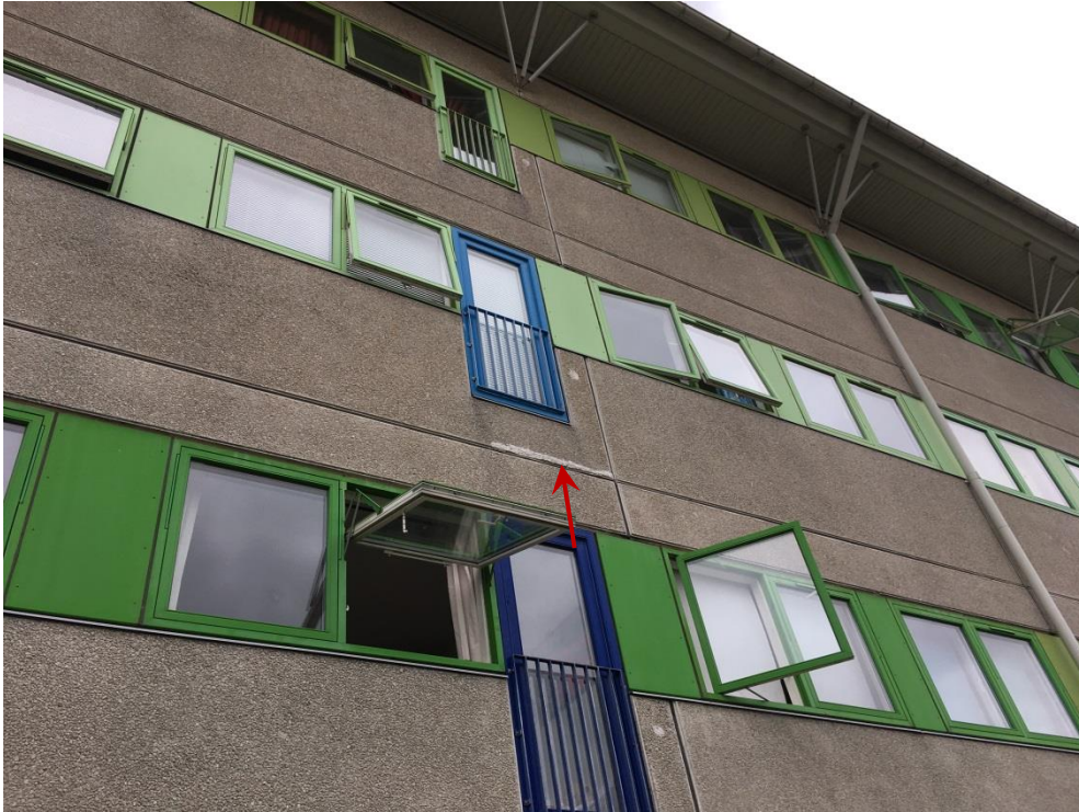
Foto 3. Lav blok. Blok 6, facade. Reparation i bund af element.
