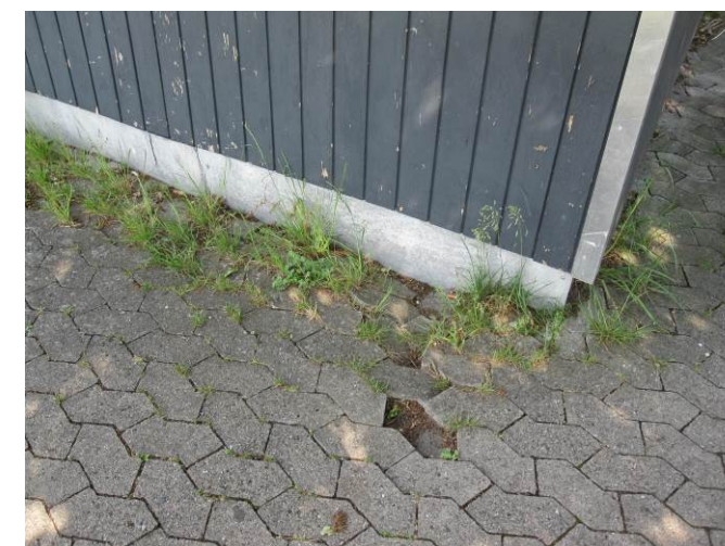
Billede 60 - sammensunken flisebelægning opad boldklubbens sokkel
