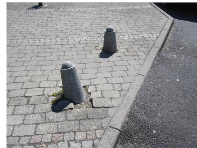
Billede 53 - pullert ved parkeringspladsen har fået et stød
