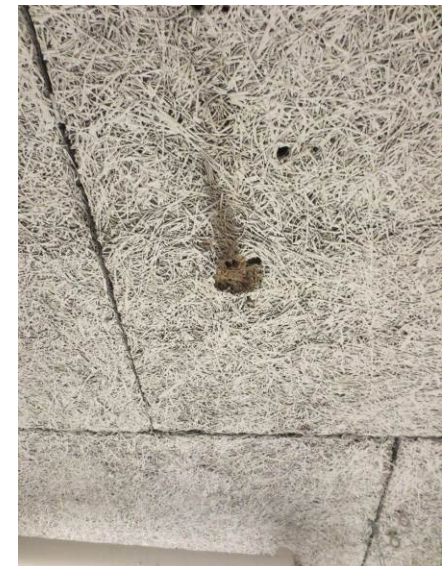
Billede 33 - der er få skader i træbetonplader som denne
