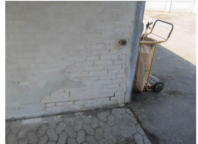
Billede 20 - forvitret murværk i port til materialegård vurderes at være fremkommet ved tøsaltning
