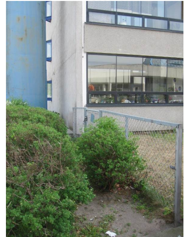
Billede 40 - fordybninger i bed over utæthed i mellemgangens ydervæg kan være medvirkende årsag til indtrængende vand
