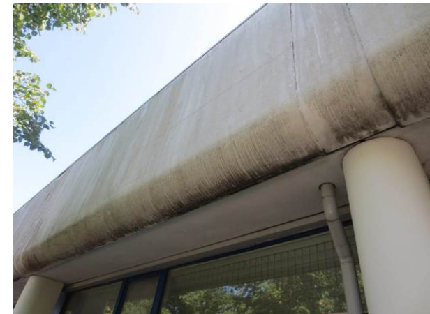
Billede 10 - stern langs biblioteket hvor tagrender og nedløb fremstår underdimensioneret
