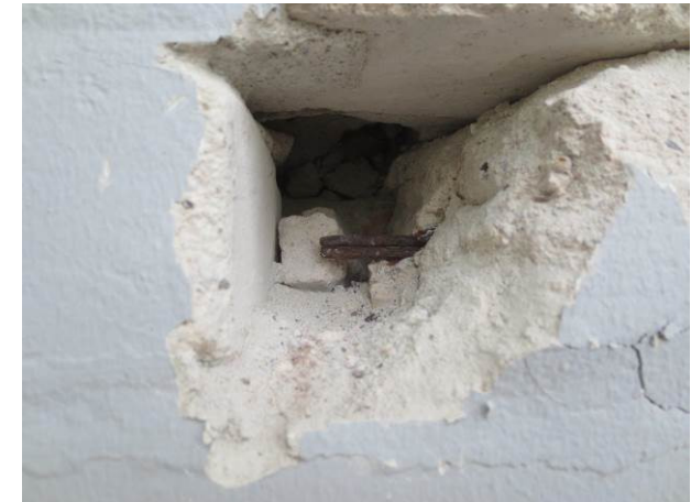
Billede 16 - korroderet armering i bjælke over dør
