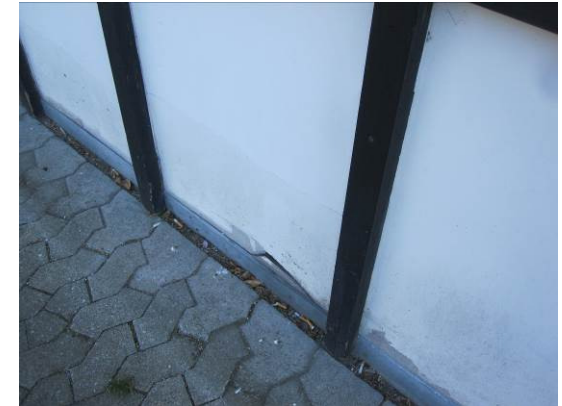
Billede 13 - skade på sokkel mod vest ved opgang 24-28
