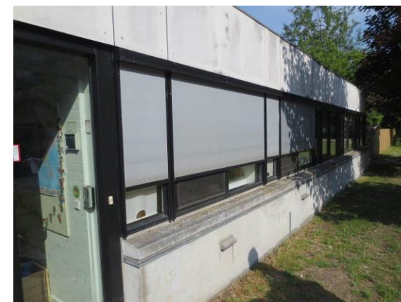
Billede 24 - Junibakkens vinduer mod øst med udvendig solafskærmning
