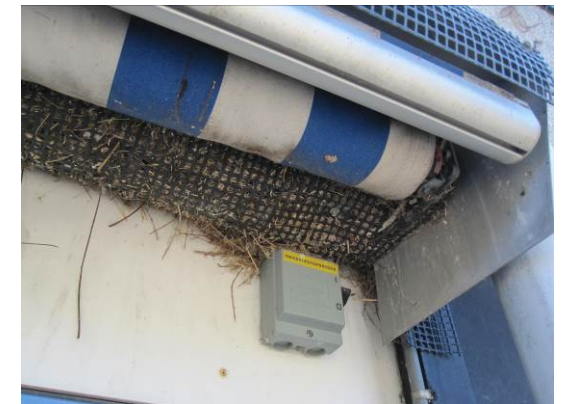
Billede 28 - fuglereder bag fuglebånd under markise på vestvendte facadeparti ved opgang 24-28
