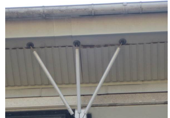
Billede 7 - løse stålplader i bygningens udhæng
