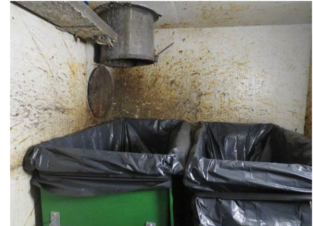
Billede 42 - affaldsrum til skakt
