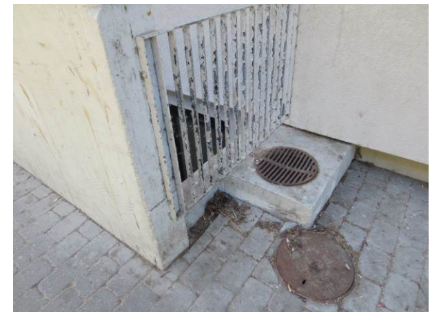
Billede 43 - afskallende maling på rækværk til bygningers nordvendte kældernedgange
