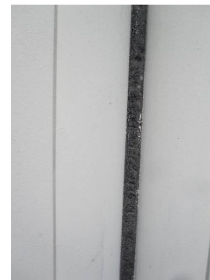
Billede 19 - fuge mellem fiberbetonskaller på sydvendt gavl
