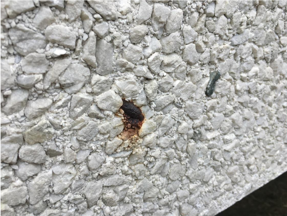
Foto 7. Høj blok. Blok 2, altanbrystning. Yderligt liggende bøjle som ruster.
