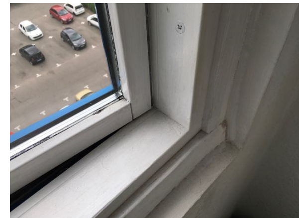
Billede 2 - vindue mod øst, rådskade i bundliste
