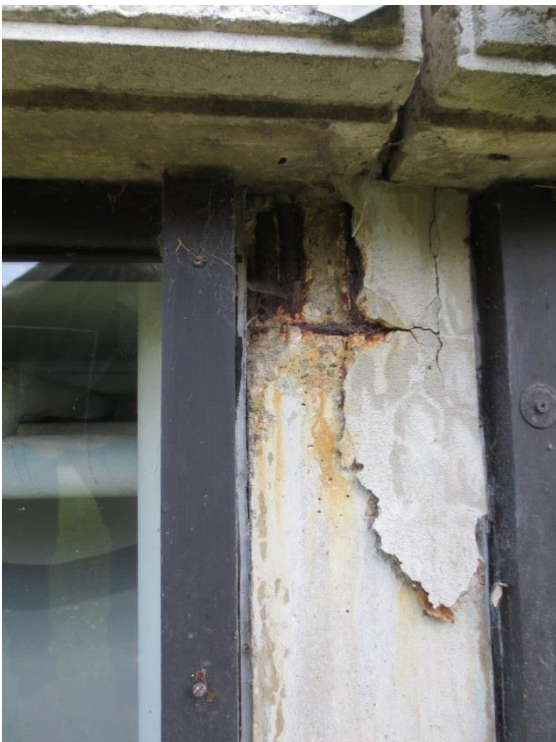
Foto 8. Foto fra rekvirenten. Høj blok, ukendt sted, havside. Afskalning over jern i søjle mellem vinduer i kældervæg.
