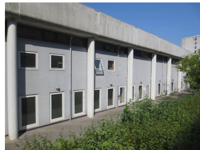
Billede 24 - orkestergraven ved bygningens østvendte facade
