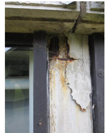
Billede 14 - afskalning på sokler, synlige jern
