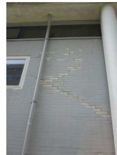
Billede 10 - eksempel på revne i murværk
