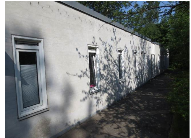
Billede 17 - Poplens østvendte facade fremstår helt uden dilatationsfuger. Der er ikke registreret dilatationsfuger på de øvrige bygninger
