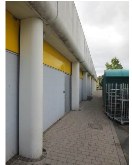
Billede 11 - vestvendt facade med ikke-bærende murværk af kalksandsten afsluttende i vinduesbånd mod tag. Foran murene ses de bærende søjler indpakket i fiberbetonskaller
