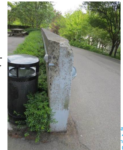
Billede 63 - trappe med betonaftskallinger vest for bygning 1 og ud for driftskontoret. Skader er her blevet udbedret
