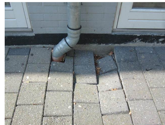
Billede 51 - sammensunken belægning
