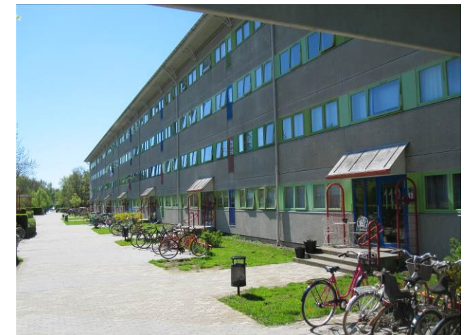
Billede 10 - østvendte facader med betonsandwich-elementer og vinduesbånd med franske altaner
