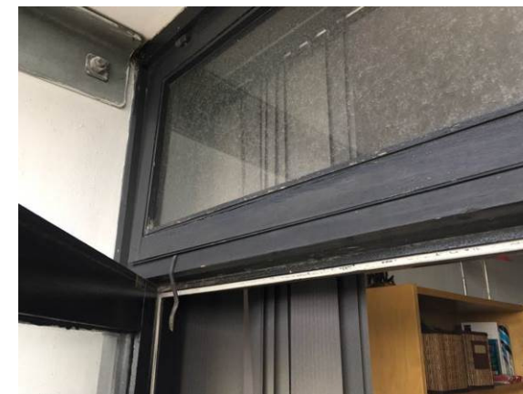
Billede 31 - skader og dårlige fuger/tætningslister på facadepartier mod altaner
