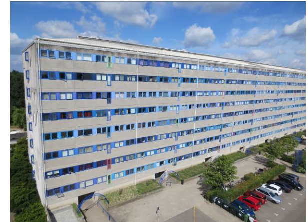
Billede 25 - østvendte vinduespartier med franske altaner
