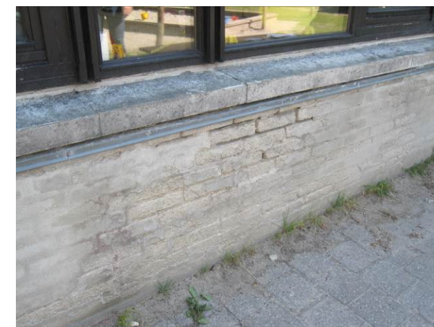
Billede 2 - forvitret murværk på Junibakkens brystning
