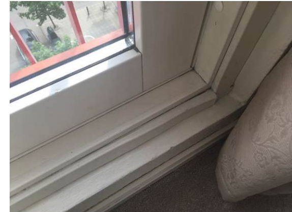
Billede 33 - opfugtet bundkarm på fransk altandør, som følge af indtrængende vand
