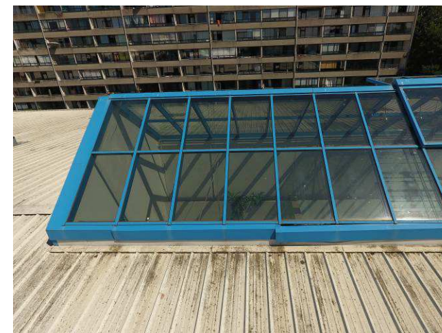
Billede 9 - løse inddækninger i glasoverdækning
