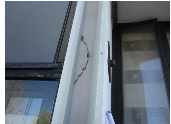
Billede 19 - afskalning på vanger mellem altaner
