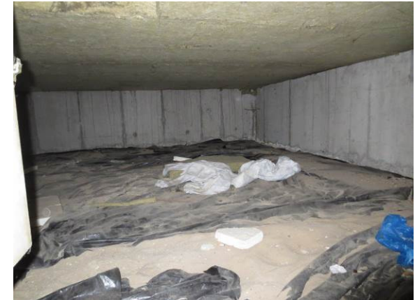
Billede 38 - krybekælder med efterisolering mod dæk til stue
