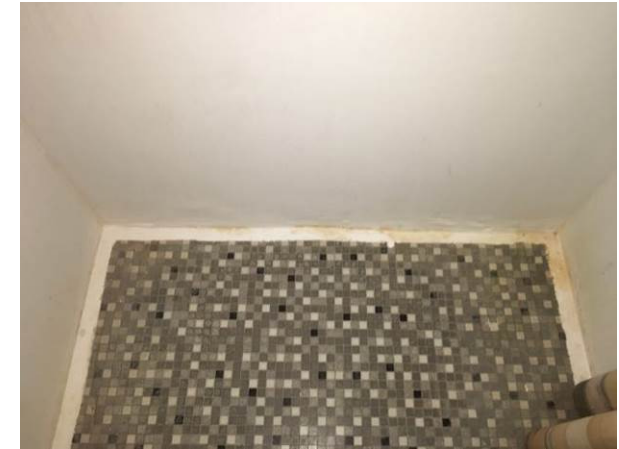
Billede 52 - slidte gulvoverflader på badeværelse
