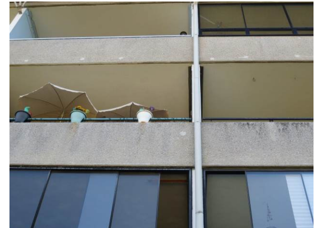
Billede 13 - mange steder ses reparationer fra tidligere betonaftskallinger (her på østvendt facade)
