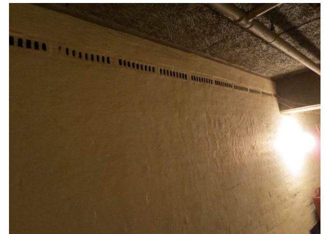
Billede 55 - ventilationssten i skillevægge af kalksandsten i kælder
