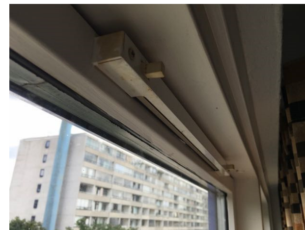
Billede 54 - lukket friskluftventil
