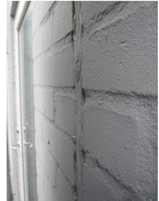
Billede 17 - dilatationsfuge med mørtelspild uden elastisk fuge
