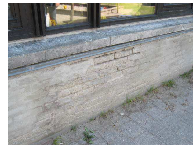
Billede 14 - forvitret murværk på Junibakkens brystning
