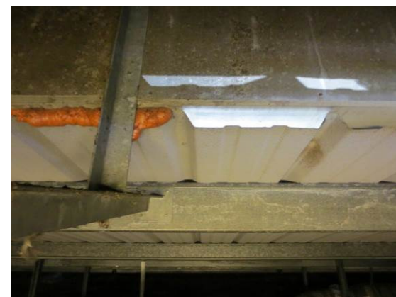
Billede 8 - udluftning aflukket med skum
