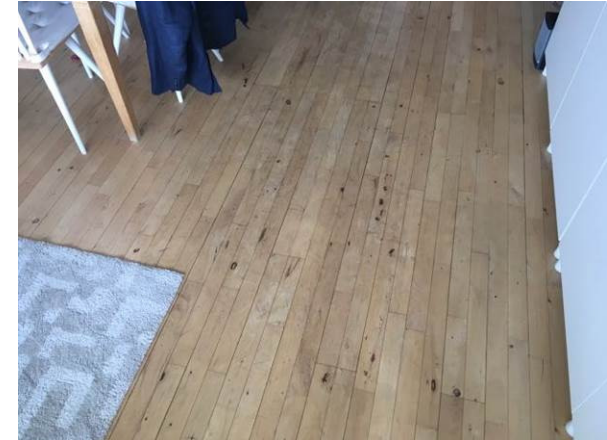
Billede 35 - slidt gulvoverflade, mange gulve knirker
