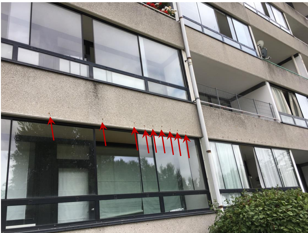
Foto 6. Høj blok. Blok 3, altanbrystning. Yderligt liggende bøjler som rustet.
