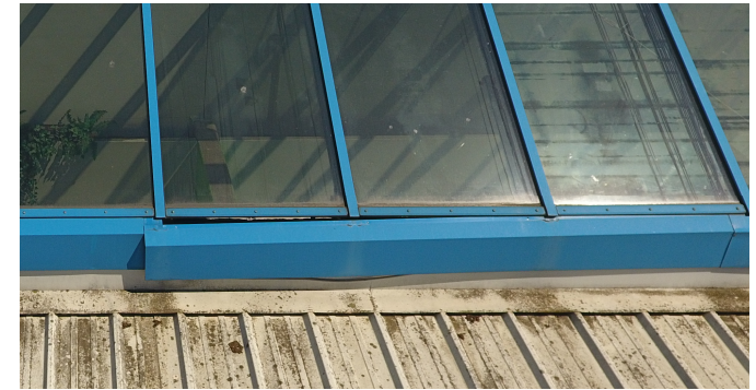
Billede 9 - løstsiddende inddækninger på glasoverbygning fremstår med direkte utæthed
