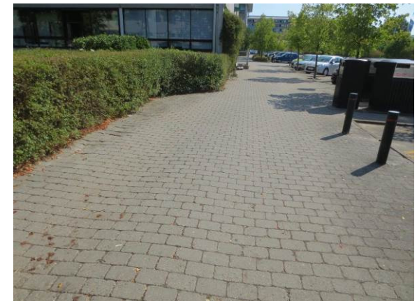
Billede 66 - flisearealer langs bygningernes sydvendte gavle fremstår med kørespor fra skraldevognen som kører her tre gange ugentligt
