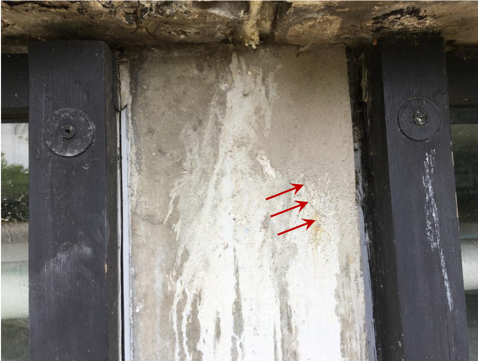
Foto 9. Høj blok. Blok 2, haveside. Reparation i søjle mellem vinduer i kældervæg. Der ses desuden en fin revne under reparationen (pile).
