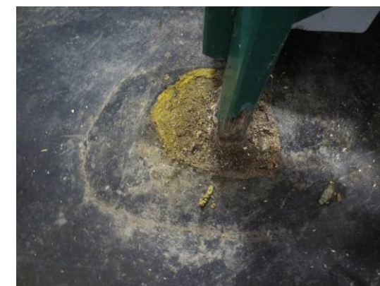
Billede 2 - vandskade ved trappers fastgørelse i kælderdæk
