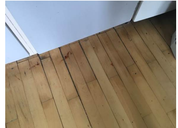
Billede 58 - slidte gulve og ubehandlede overflader fra nedtagning af tidligere køkkenelementer
