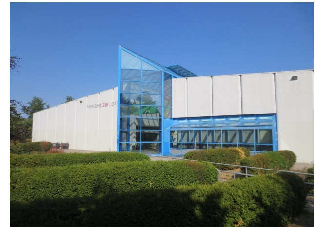
Billede 12 - sydvendt gavl beklædt med fiberbetonskaller
