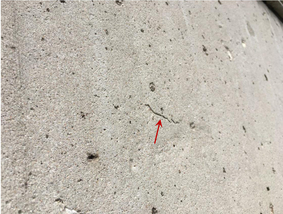
Foto 13. Høj blok. Blok 3, facade, kældervæg. Begyndende afskalning (pil).
