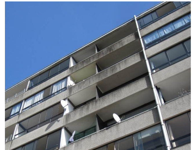
Billede 20 - algebegroinger/misfarvninger på øverste altaner
