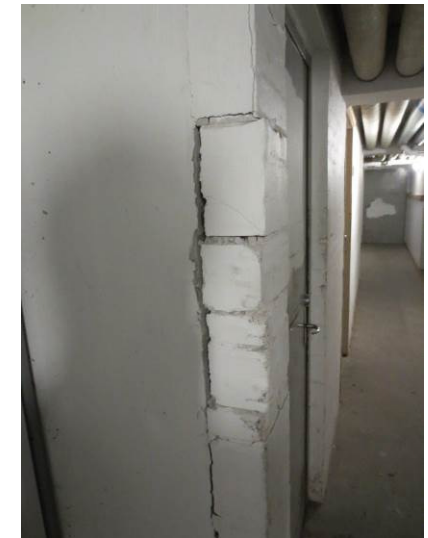
Billede 3 - skader på vægstykke i kældergang, som følge af skraldepersonalets arbejdsgang
