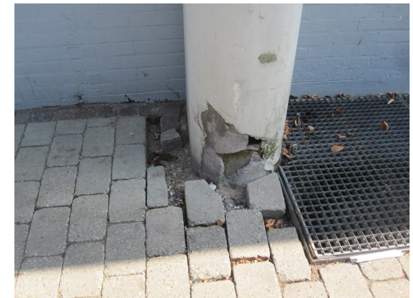
Billede 14 - skadet fiberbetonskal på søjle
