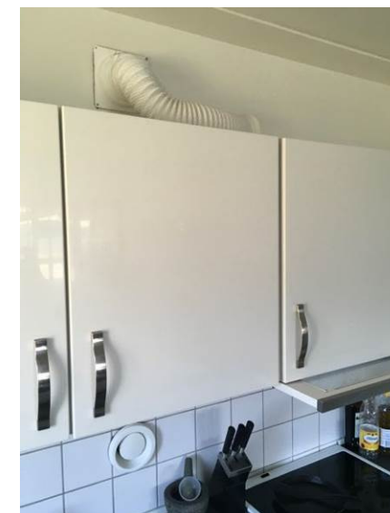
Billede 60 - emhætten ses flere steder koblet på kontrolventilerne med flexslange
