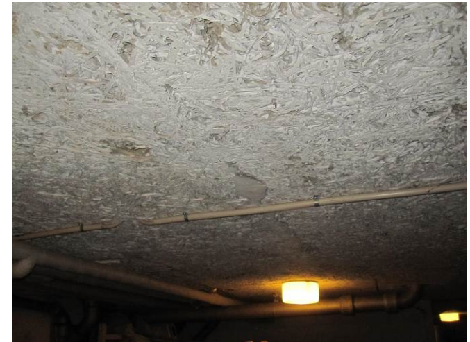
Billede 31 - kælderloft med blivende forskalling af træbetonplader
