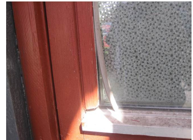
Billede 30 - løstsiddende tætningsliste på vindue i boldklubbens køkken
