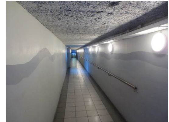
Billede 39 - sammenbygningen mellem parterregangens nordlige ende i bygning 2 og mellemgang
