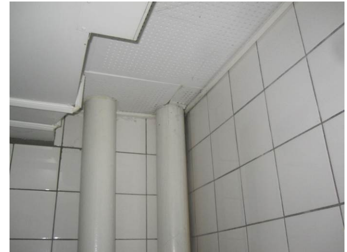
Billede 10 - utæt tagnedløb i Bakken er placeret umiddelbart ved siden af faldstammeduflutning i wc-rum
