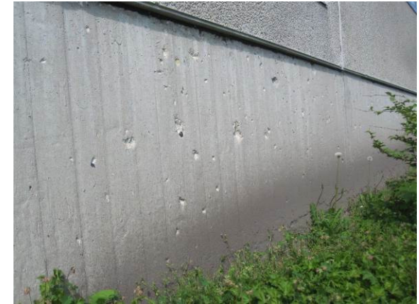
Billede 37 - betonaftskallinger udvendigt på kælderydervægge
