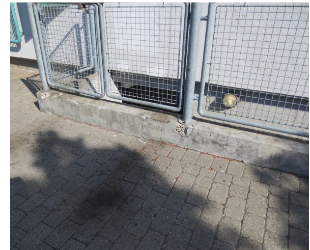
Billede 41 - betonafskalninger på udvendige trappenedgang til kælder
