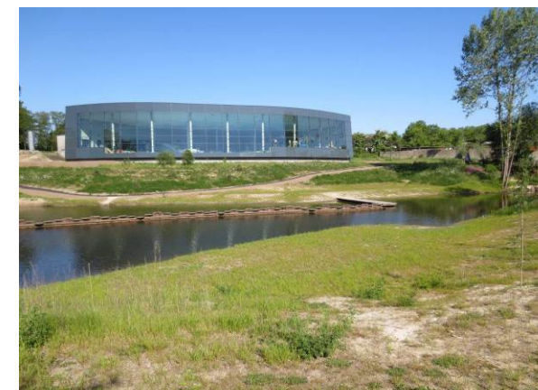
Billede 64 - søen vest for bygning 8 anvendes til afledning af overfladevand for hele området
