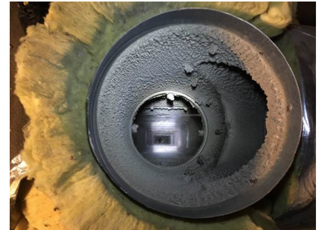
Billede 3 - manglende rengøring af kanalsystem
