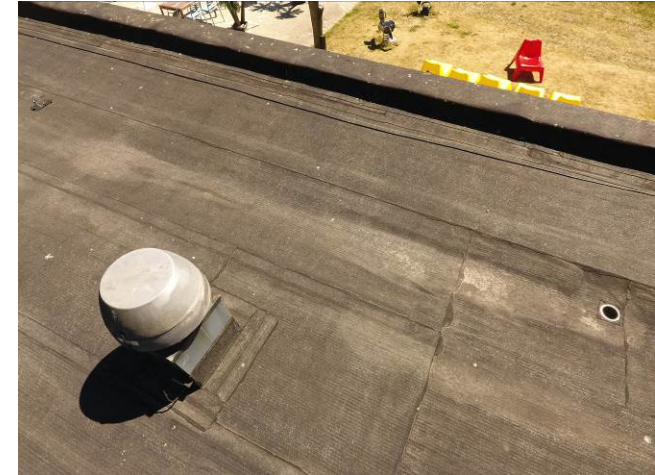
Billede 9 - derbigum fremstår med synlige fibre. Der mangler bladfang på de fleste afløb
