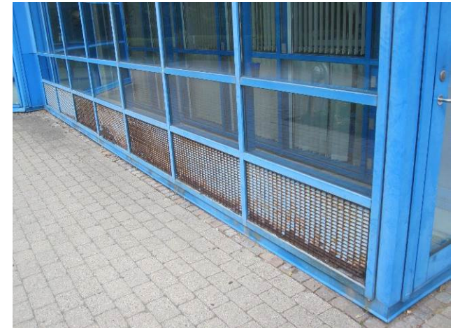
Billede 29 - ventilationsriste i glasoverdækning til kældertrappe fremstår tæret
