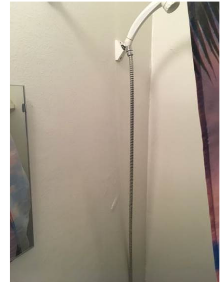
Billede 49 - udposning i maling på væg bag brusestang
