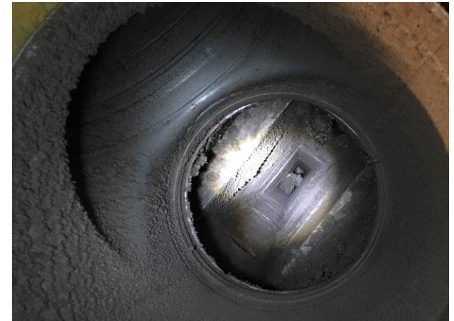
Billede 4 - manglende rengøring af kanalsystem
