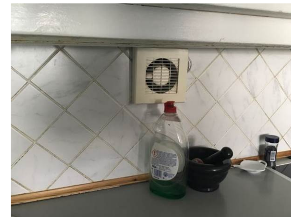
Billede 56 - nogle beboere fjerner kontrolventilerne i køkkenet og andre udskifter dem til andre typer eller som her monterer ventilatorer
