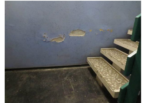
Billede 44 - udposninger og afskalninger i maling og puds på væg i trappeopgangens ydervæg
