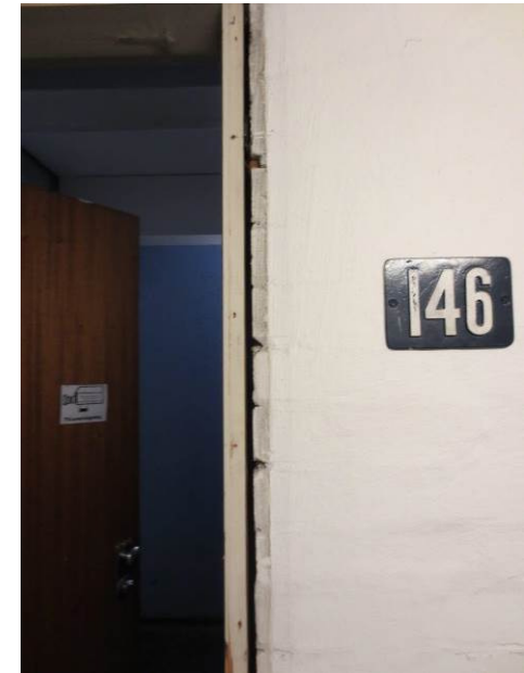
Billede 35 - skadet indfatning på kælderdoor til trapperum
