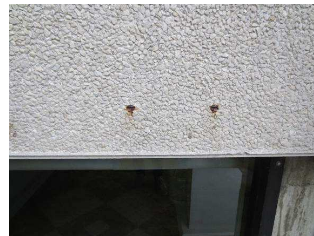
Billede 1 - betonafskalninger på altan
