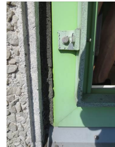
Billede 33 - fugebånd der synker ned ved opvarmning på varme dage
