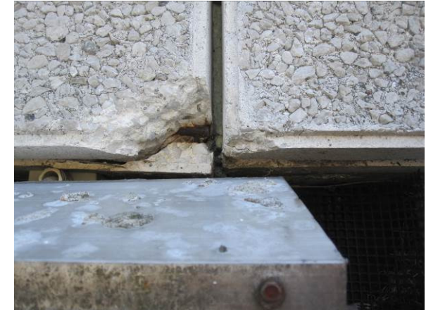
Billede 17 - blotlagt jern nederst i altanbrystning
