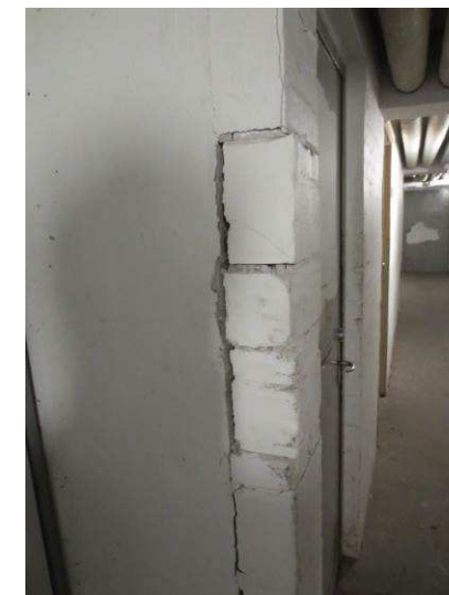
Billede 8 - skader på vægstykke i kældergang, som følge af skraldepersonalets arbejdsgang
