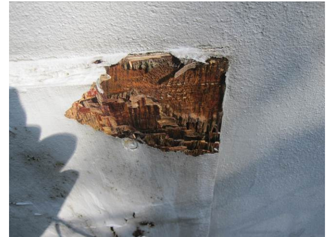
Billede 35 - rådnet krydsfinerplade ved trappenedgang til Poplens kælder
