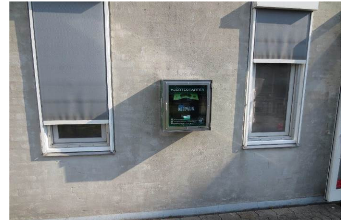
Billede 49 - vinduer i beboerhuset med manuelt styret solafskærmning
