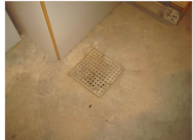
Billede 36 - gamle afløb uden højvandslukker
