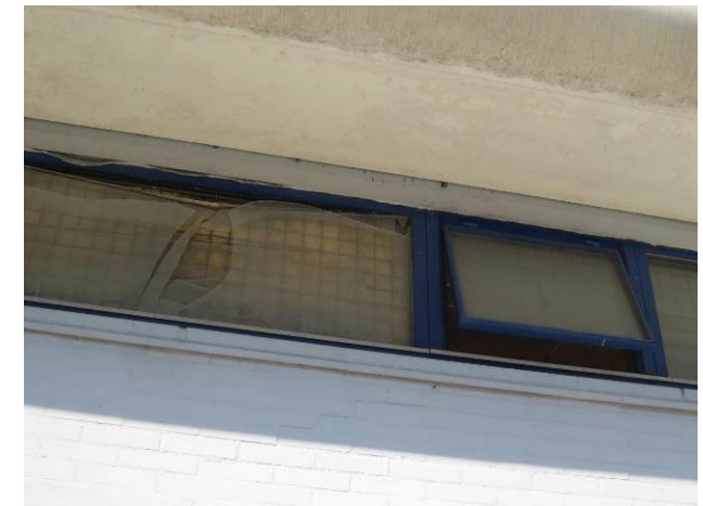
Billede 30 - vinduesbåndene fremstår slidt og uvedligeholdt
