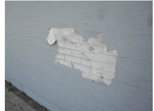
Billede 13 - afskallende maling på vestvendt facade
