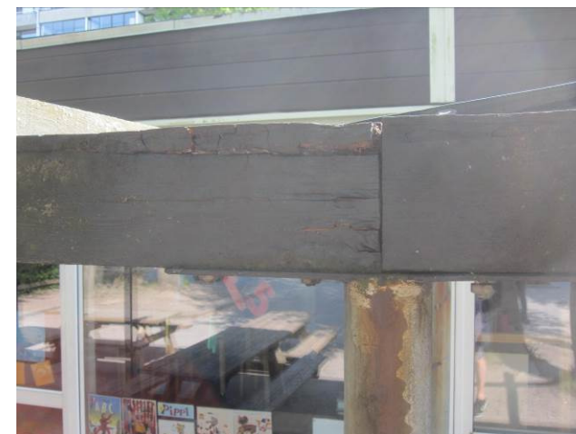
Billede 44 - opfugtet og rådnet træværk på terrasseoverdækning ved Bakkens vestvendte facade
