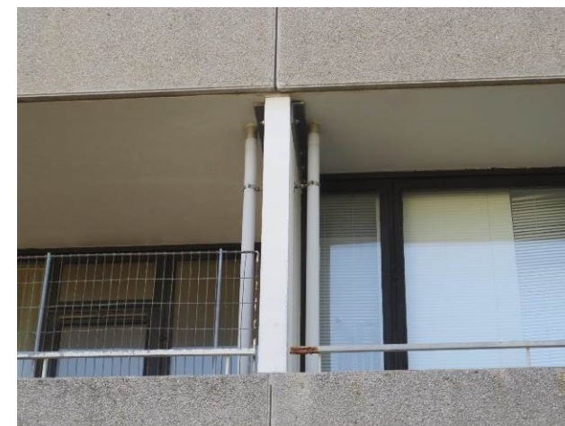
Billede 16 - nedløb for afvanding af altaner
