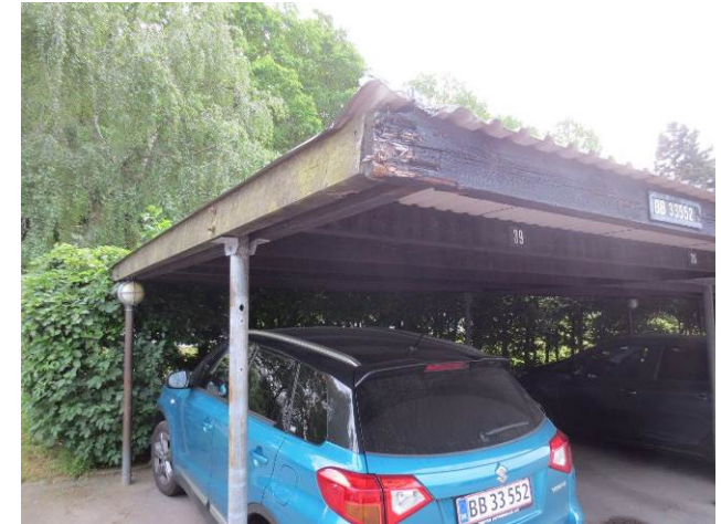
Billede 46 - råddent træværk på carport
