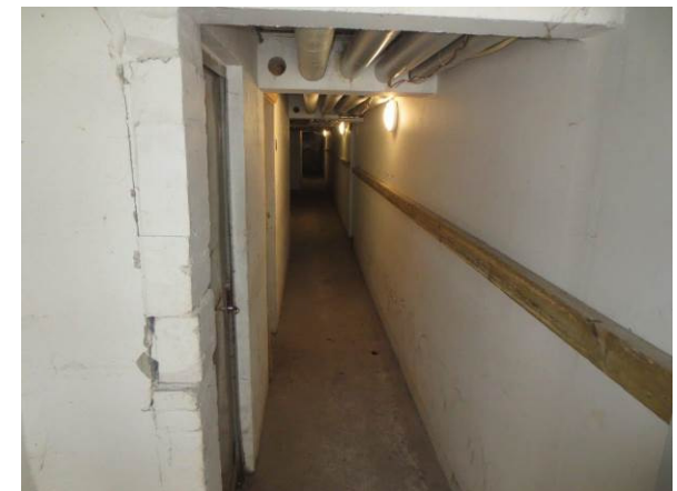
Billede 45 - stødsikring på væg i kældergang. Der er registreret i én af de tre registrerede kældergange
