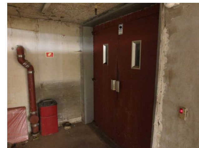
Billede 61 - elevator i Nettokælderen
