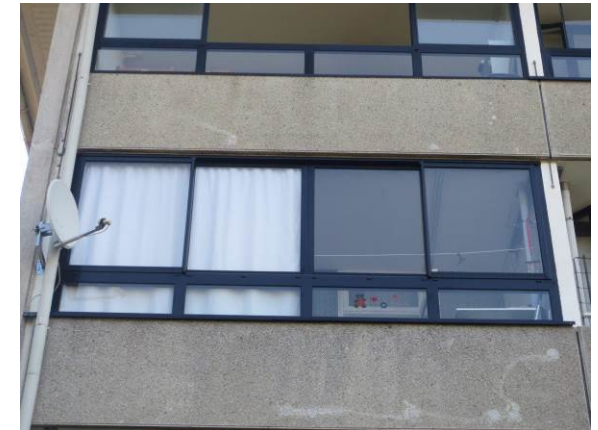
Billede 22 - lukket facadeparti (klimaskærm) på altanbrystning
