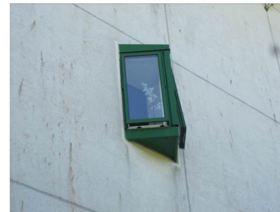
Billede 25 - vindue i gavl
