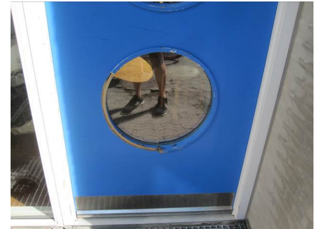
Billede 27 - indgangsdøren til Bakken fremstår med manglende glasliste på rude
