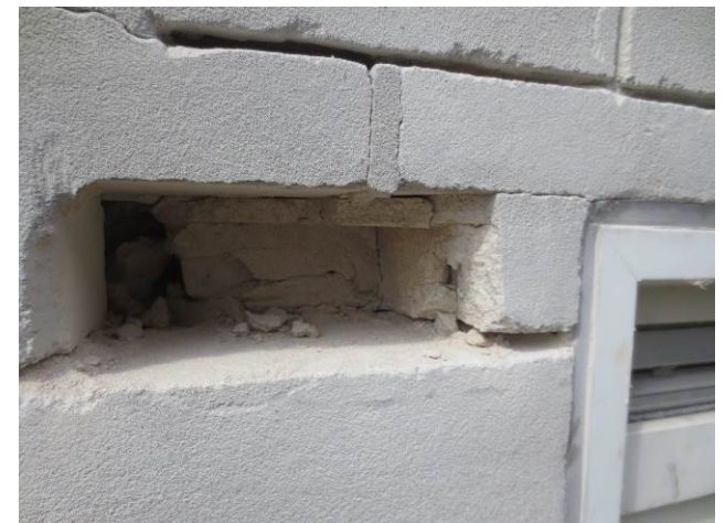
Billede 18 - undersøgelse af murværket i beboerhuset viser at facademurværkets for- og bagmur er sammenmuret i vinduesåbninger
