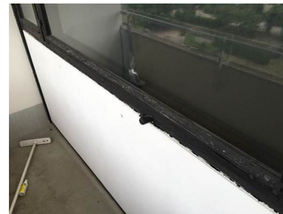
Billede 27 - afskallende maling på facadeparti
