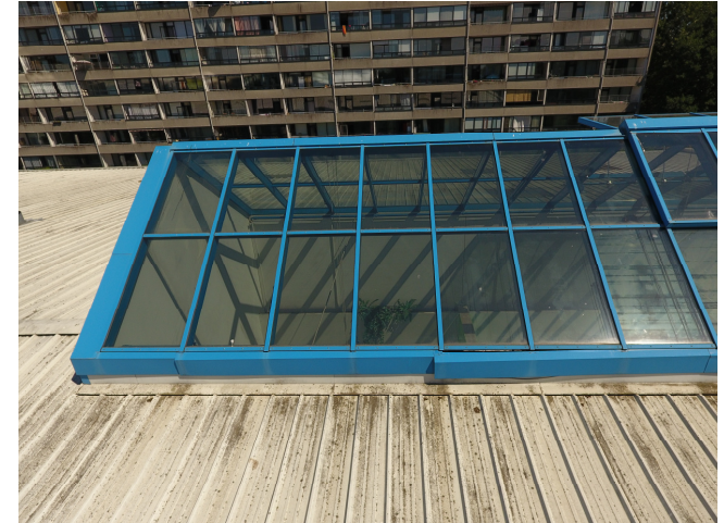
Billede 1 - løse inddækninger i glasoverdækning
