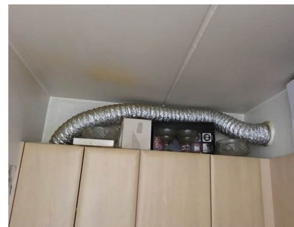
Billede 52 - emhætte tilkoblet kontrolventil
