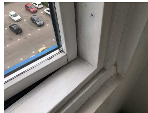
Billede 2 - vindue mod øst, rådskade i bundliste
