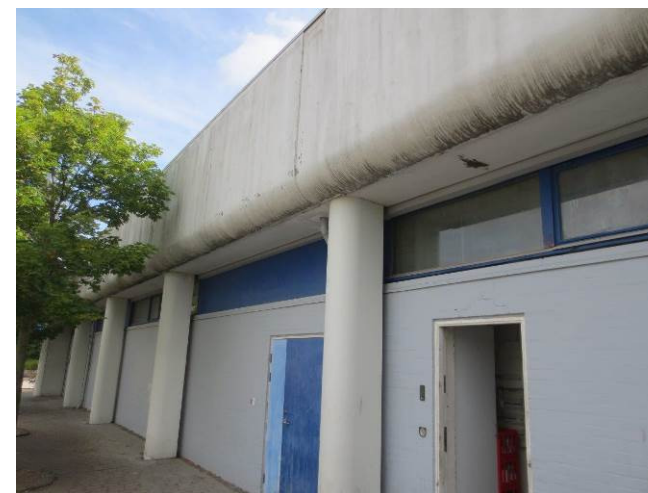
Billede 23 - vinduesbånd over facademurværk
