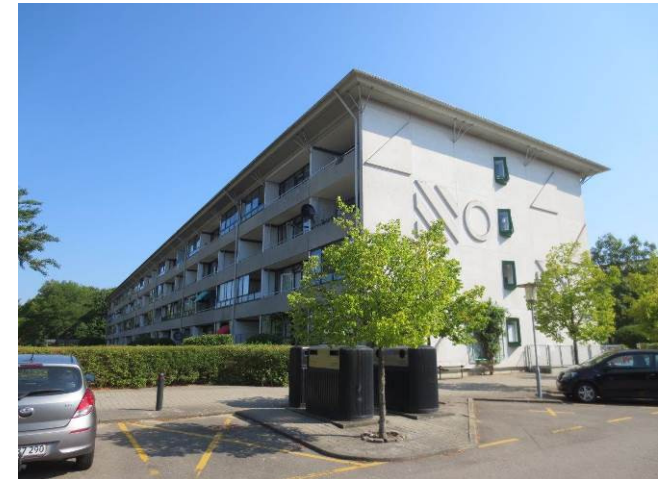
Billede 9 - gavl vestvendt facade, lejlighedsskel ses mellem altanerne
