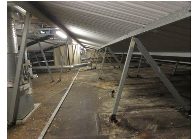
Billede 5 - tagrum: den nye tagkonstruktion ses bygget direkte på oprindelige tagflader
