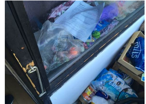
Billede 30 - skader på facadeparti mod altan
