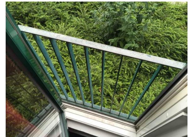
Billede 18 - stålgitre på franske altaner fremstår med afskallende maling og enkelte steder med korrosion
