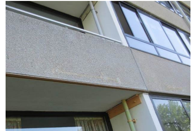
Billede 20 - betonreparation nederst på altanbrystning
