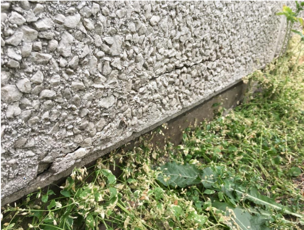
Foto 1. Lav blok. Blok 4, facade. Begyndende afskalning i bund af element.
