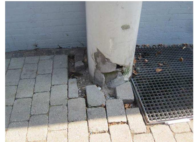
Billede 11 - skade på fiberbetonskal
