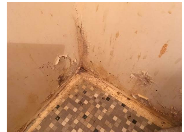
Billede 50 - fugtskade på væg over gulv
