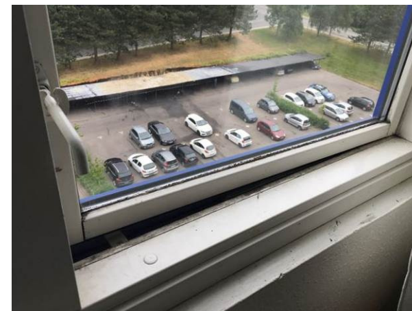
Billede 51 - utæt tætningsliste på østvendt facade
