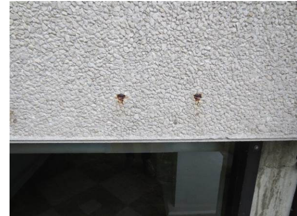
Billede 1 - betonafskalninger på altan
