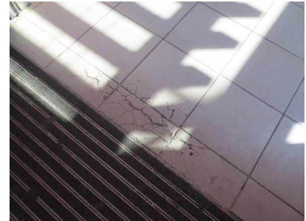
Billede 58 - eksempel på skader i centergangen. Her en knækket flise
