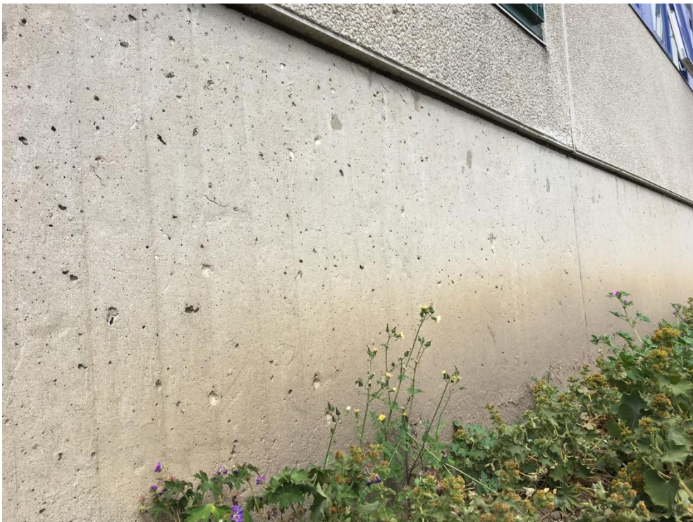
Foto 12. Høj blok. Blok 3, facade, kældervæg. Der ses en del afskalninger i form af springere over frostfarlige korn. Der ses ligeledes begyndende afskalninger.
