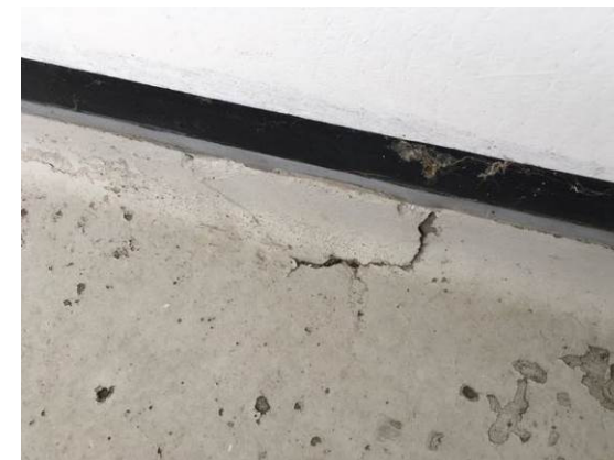
Billede 1 - betonafskalninger på altandæk
