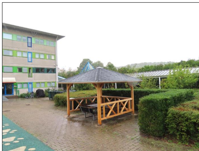
Nyopført pavillon v/blok 7
