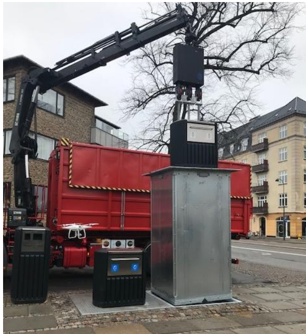
Beholderen under jorden løftes op og tømmes af kranarm.
